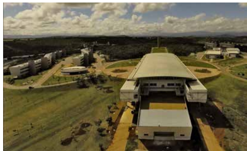
Prédio do Comando
